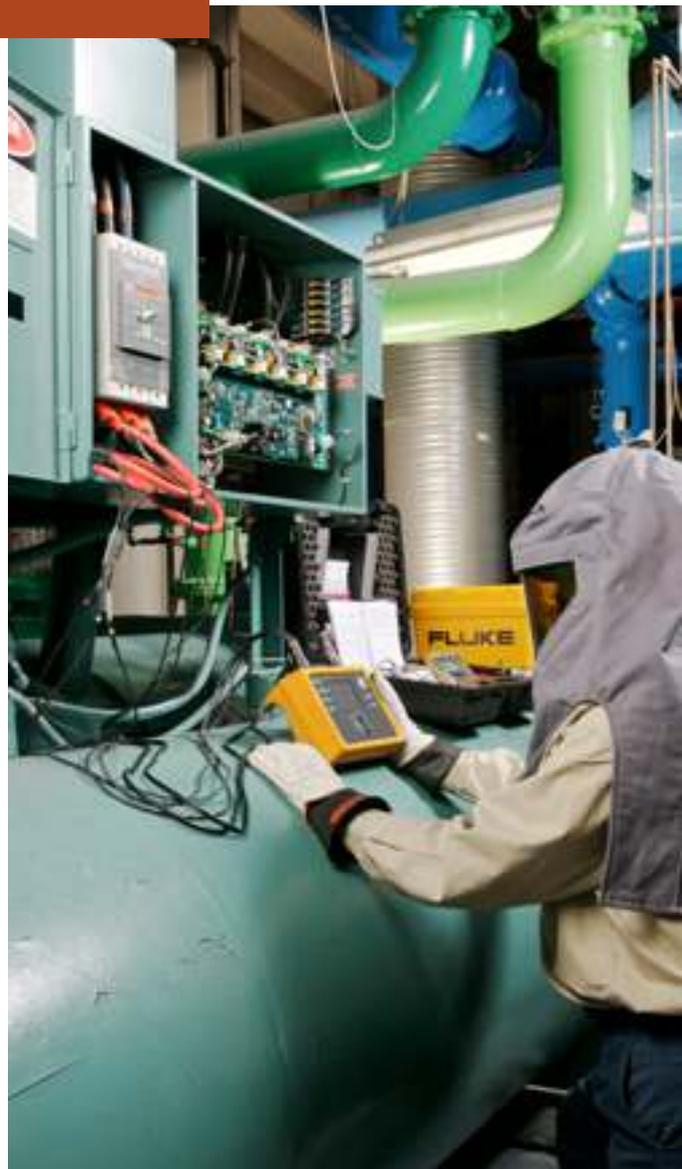
Utilizzo di un registratore di rete Fluke 1735 per registrare il consumo energetico su un refrigeratore in modo da determinare l'efficienza dell'impianto.
