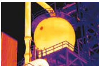
Ispezione dell'isolamento refrattario in un reattore petrolchimico.
