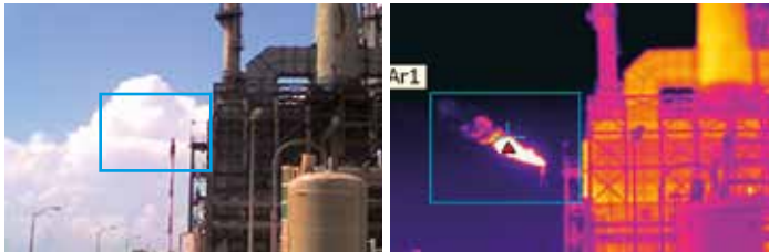
Una termocamera può monitorare le fiamme invisibili ad occhio nudo. Notare la fiamma invisibile nell'immagine di sinistra.
