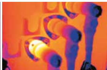
Surriscaldamento dei collegamenti
