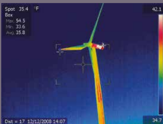
Immagine termica di una turbina eolica ripresa dal suolo
