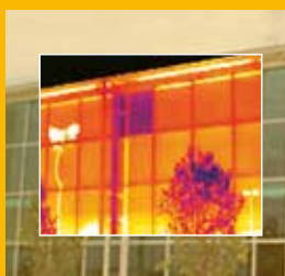
Ispezione termografica di una vetrata.
