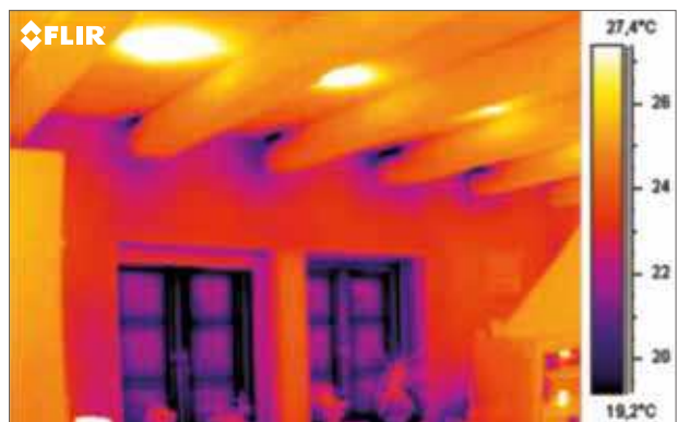
L'immagine termica evidenzia i ponti termici tra le travi del tetto ed il muro adiacente.
