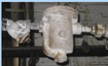
In caso di corretto funzionamento, come mostrato in questo esempio, le immagini termiche degli scaricatori di condensa devono mostrare un brusco cambiamento di temperatura.
