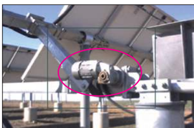
Un motore con riscaldamento eccessivo a causa di un problema di isolamento
