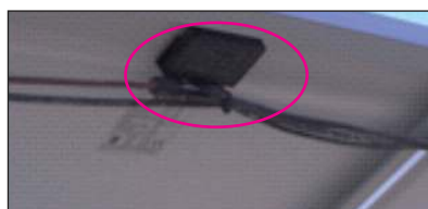
Connessioni e scatola dei diodi di protezione
