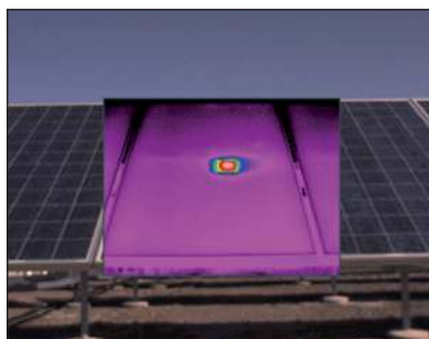
Un pannello fotovoltaico con cella difettosa
