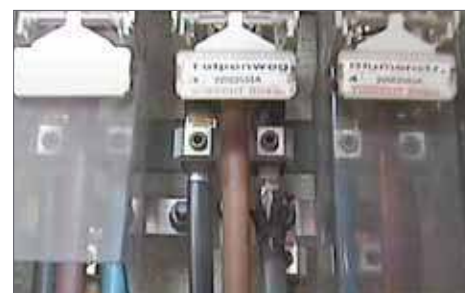
Questo connettore presenta resistenza a causa di allentamento e corrosione. Si può facilmente riparare aprendo, pulendo e ri assemblando il connettore.
