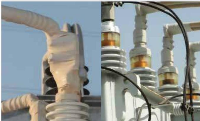
*Il guasto di un isolatore può causare gravi danni al trasformatore e ad altre apparecchiature e mettere a rischio la sicurezza del personale*
