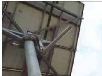
*L'ispezione dalla parte posteriore non evidenzia punti caldi, portando a concludere che i punti caldi dell'immagine precedente ripresi dalla parte anteriore erano in realtà causati dai riflessi delle nuvole.*
