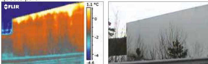
*Un magazzino con una significativa fuoriuscita di aria calda tra i muri e il tetto. Queste giunzioni devono essere migliorate per arrestare la forte perdita energetica.*
