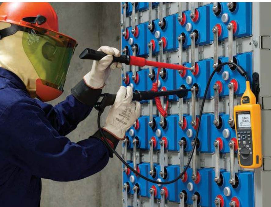
Misurare i valori resistivi in sequenza
